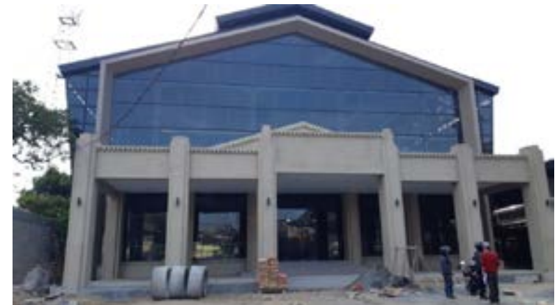
KOMPAS/HARIS FIRDAUS--Sejumlah orang melihat kondisi gedung tempat relokasi pedagang kaki lima (PKL) yang dibangun di lahan bekas Bioskop Indra di kawasan Malioboro, Kota Yogyakarta, Jumat (27/9/2019). Gedung itu rencananya akan dipakai untuk menampung PKL di kawasan Malioboro.
