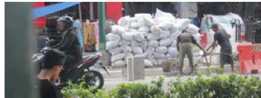
KOMPAS/HARIS FIRDAUS--Sejumlah pekerja tengah mengerjakan pembangunan trotoar sisi barat kawasan Malioboro, Kota Yogyakarta, Rabu (1/8/2018). Hingga Juli 2018, proyek pembangunan trotoar sisi barat Malioboro baru mencapai 46 persen, padahal proyek itu ditargetkan selesai Desember 2018.
