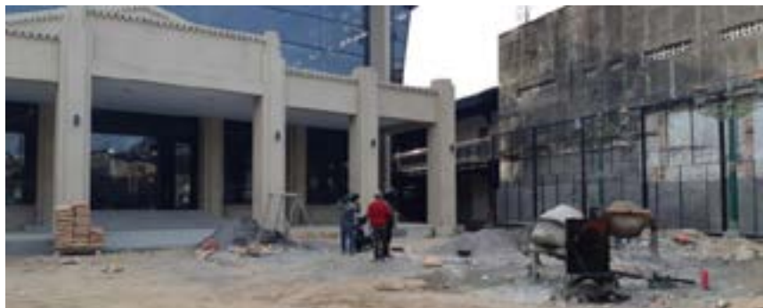
KOMPAS/HARIS FIRDAUS--Sejumlah orang melihat kondisi gedung tempat relokasi pedagang kaki lima (PKL) yang dibangun di lahan bekas Bioskop Indra di kawasan Malioboro, Kota Yogyakarta, Jumat (27/9/2019). Gedung itu akan dipakai untuk menampung PKL di kawasan Malioboro.
